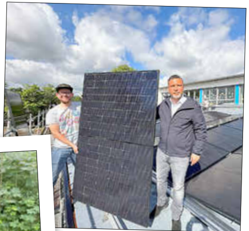
Sonne bringt Energie: neue PV-Anlage installiert
