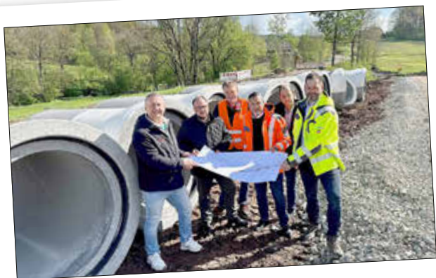
Radweg- und Druckleitungsbau Wohlbach-Schafhof
